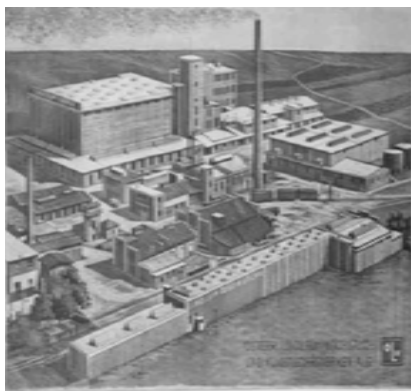
Abb. 6-5: Situation am ehemaligen Altlastenstandort in Brunn am Gebirge bis 1974 vor der Flächenrevitalisierung [Schad 2007]. Dargestellt ist das Gelände der ehemaligen „Linoleumfabrik Brunn“ der österreichischen Linoleum-, Wachstum- und Kunstlederfabriken A.G.
