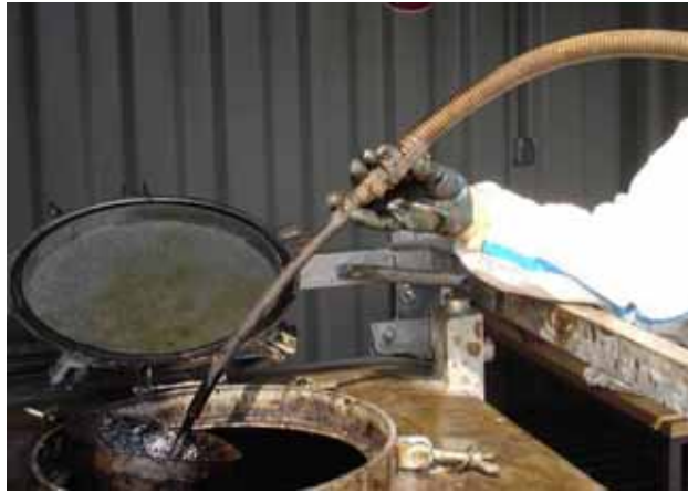
Abb. 5-7: Gefördertes Teeröl vom Standort der ehemaligen Teerfabrik in Offenbach. Das Teeröl wurde direkt aus einem Brunnen abgepumpt und bis zur weiteren Entsorgung in speziellen Tanks gelagert (CDM Consult GmbH).
