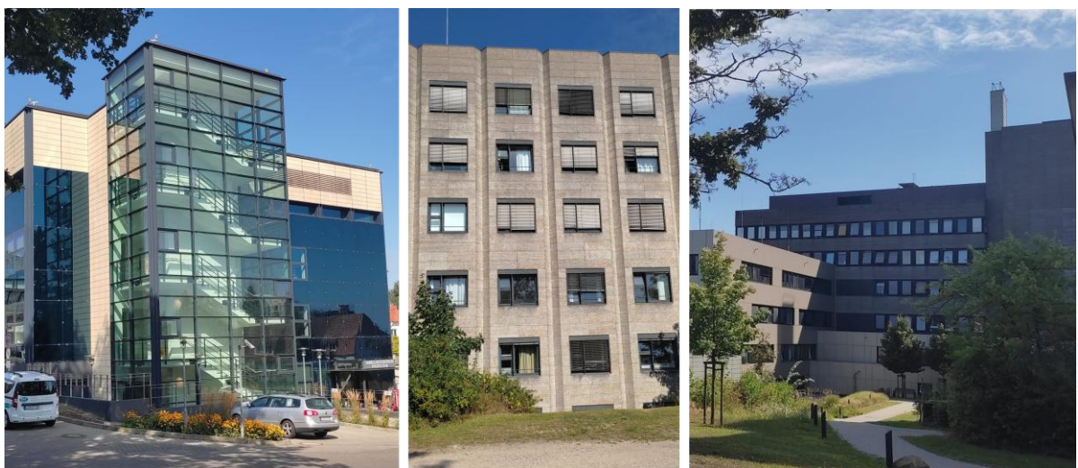
Abbildung 9: Glasfassade Gebäude N (links), Muschelkalkfassade Gebäude C und D (Mitte), Gebäude A und L mit Innenhof (rechts)
