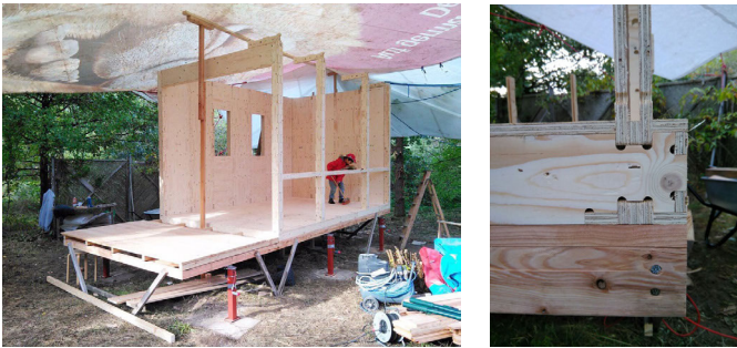
Abb. 80/81: Aufbau des ersten CNC-OS-Tiny-House-Prototyps.
