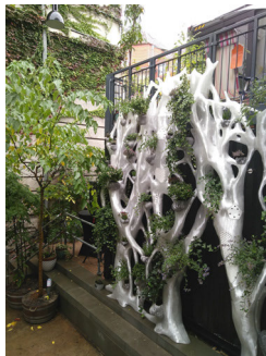
Abb. 20: Eine 3D-gedruckte Struktur, in der Pflanzen vertikal an der Hauswand des temporären Future Fiction Forum wachsen können.
