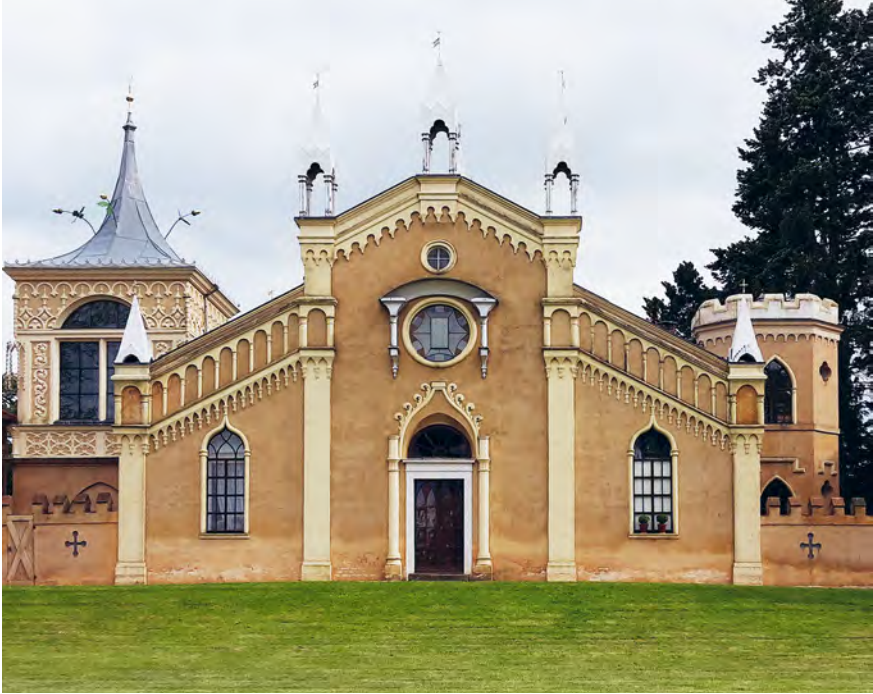
2 Wörlitz, Gotisches Haus, Kanalseite, 1773/74
