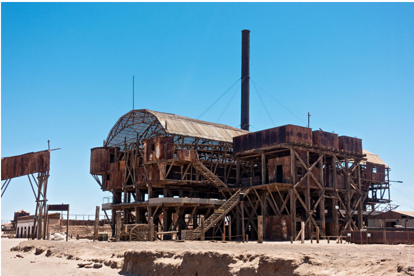
Abbildung 12: Verarbeitungsanlage der Oficina Santa Laura
