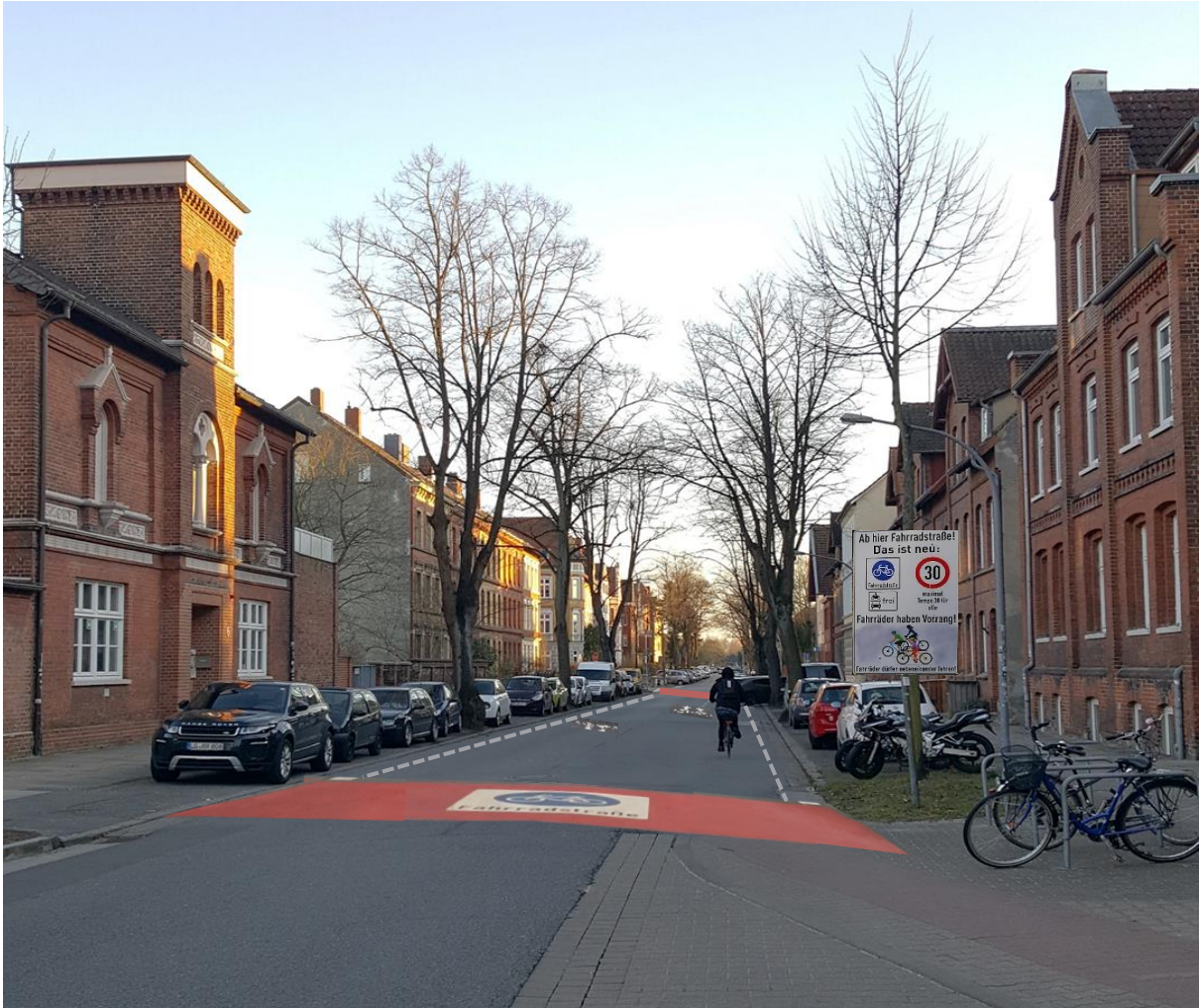
Abb. 26 Darstellung der möglichen Umgestaltung des nördlichen Anfangs der Barckhausenstraße zur Fahrradstraße. Quelle: eigene Darstellung.
