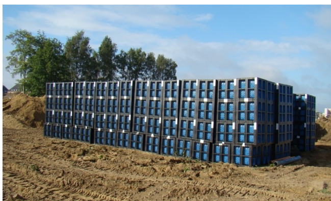
Abbildung 9: Bebauungsplan Nr. 129 (1. Änderung) Schlieffen-Park: Versickerungsboxen. Niemann 2018
