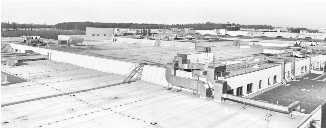
Abbildung 57: Dachfläche eines Einkaufszentrums 512
