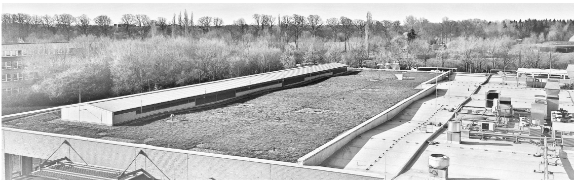
Abbildung 45: Begrünte Dachfläche eines Einkaufszentrums 425
