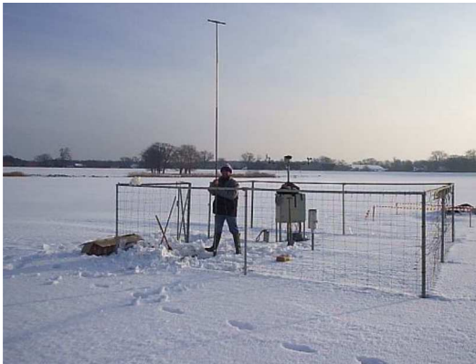
Abb. 4.5: Bohrung der Grundwassermessstation, Jan. 2010 (Foto: Emilio Torres)
