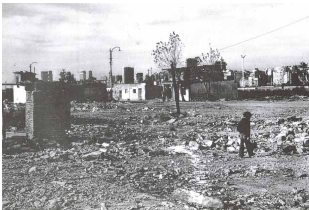
Die Villa 31 während und nach der Zwangsräumung durch das Militär 1979
