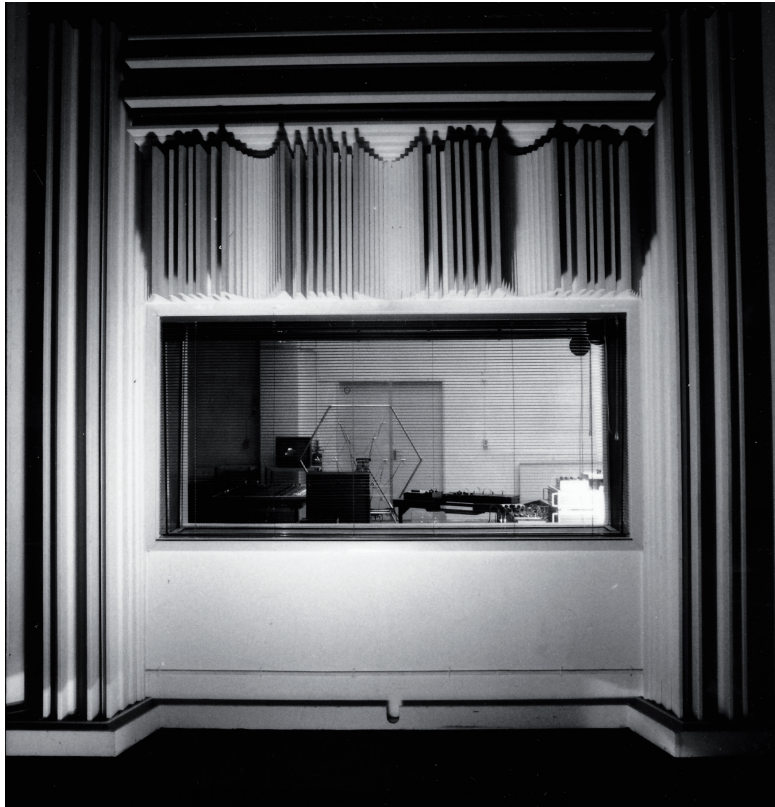
Abb. 3.14. Blick aus Studio 2 in Studio 3 des STEIM, wo während des Touch-Festivals 1998 das „Big Web“ aufgebaut war. Über und neben der Scheibe befinden sich die Schröder-Diffusoren.
