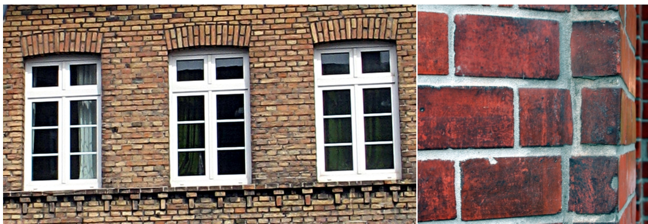
Abb. 4.16: Mauerwerkdetails: Fries, Teilsteine Gebäude: Wallstr. 16 (l); Görgestr. 13 (r) Fotos: Döring (l, Quelle: Leuphana Universität Lüneburg 2012), Seidel (r).
