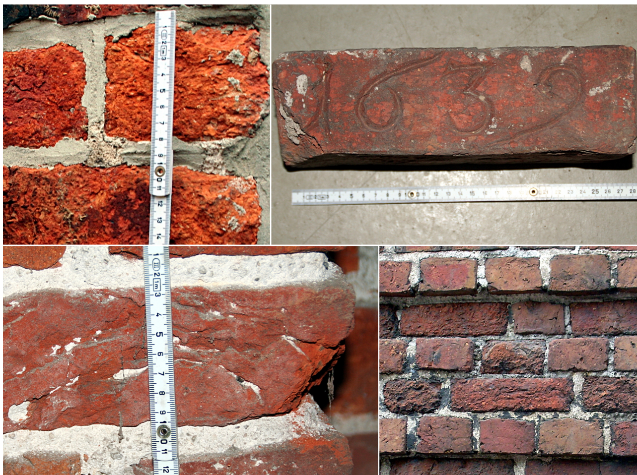
Abb. 4.3: Verwerfungen als Spuren des Handstrichs
