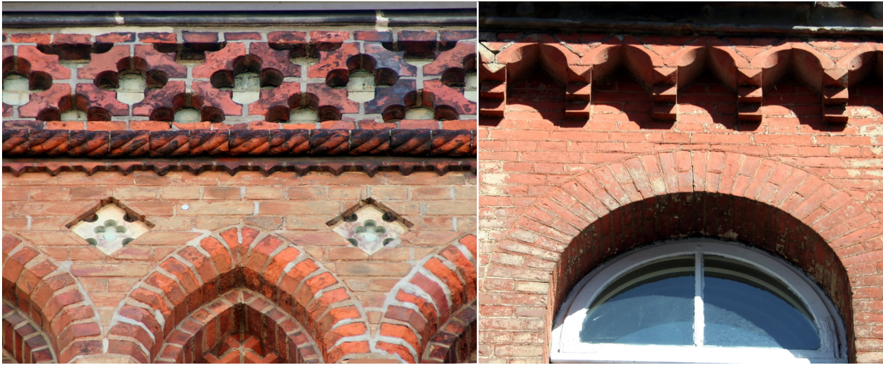
Abb. 4.25: Formsteine der zweiten Hälfte des 19. Jh. Gebäude: Am Sande 9, Fassade von 1859 (l); Obere Schrankenstr. 5, 1862 (r) Fotos: Seidel.
