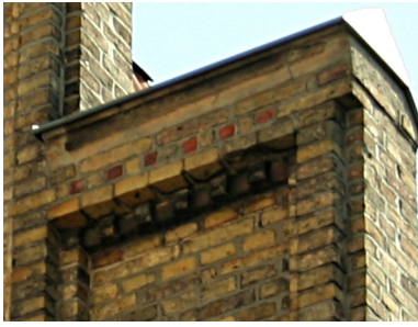
Abb. 4.23: Farbig abgesetzte Riemchen über einer Staffelblende Gebäude: Bardowicker Str. 3 Foto: Seidel.
