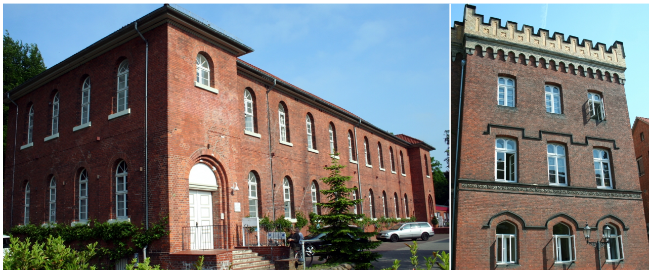
Abb. 4.22: Mauerwerk aus einfachen Formsteinen, frühes 19. Jh. Gebäude: Beim Benedikt 10, 1837 (l); Am Ochsenmarkt 3, 1845-49 (r) Fotos: Seidel.
