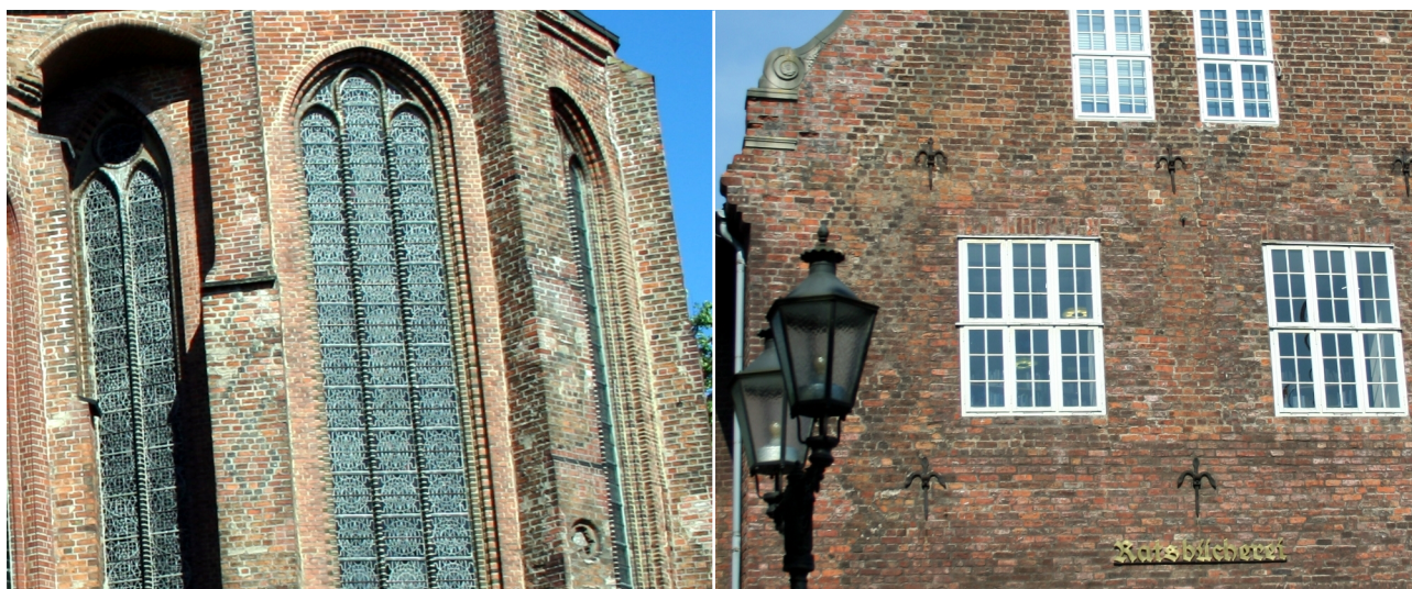
Abb. 4.18: Rautenmuster: dunkle Binder im Mauerwerk Gebäude: St. Johannis (l); Am Marienplatz 3 (r) Fotos: Seidel.
