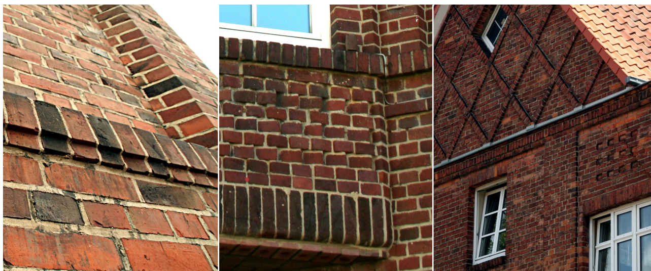
Abb. 4.28: Rückgang der Verwendung von Formsteinen im 20. Jh.
