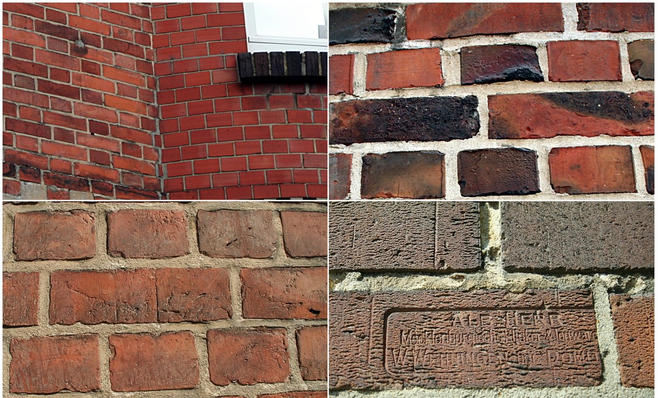
Abb. 4.5: Mauerwerk im Vergleich
