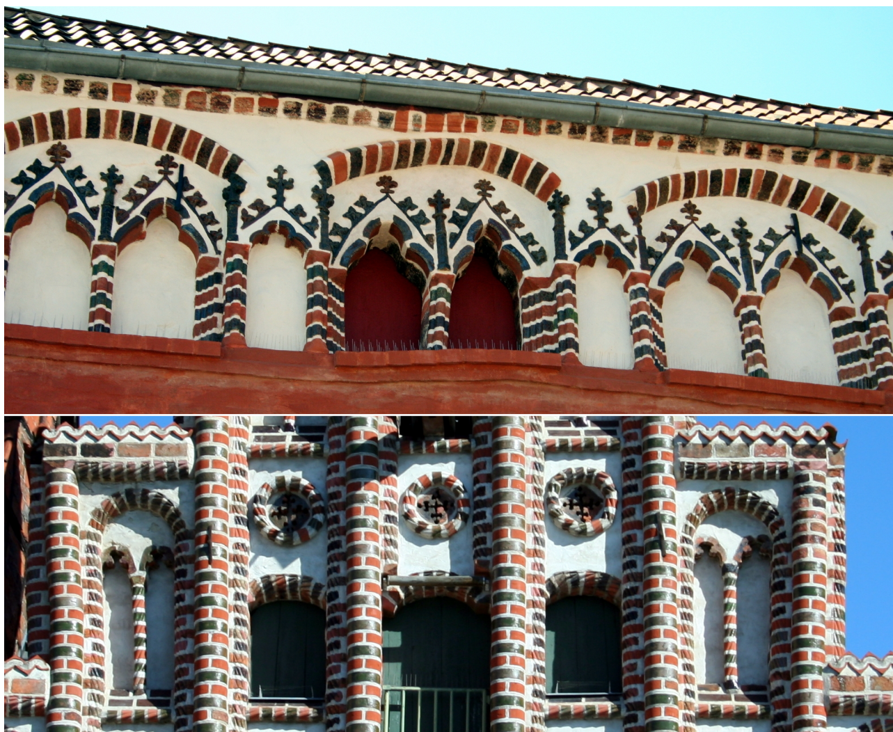
Abb. 4.20: Formsteine an Bauten des 15. und 16. Jh.
