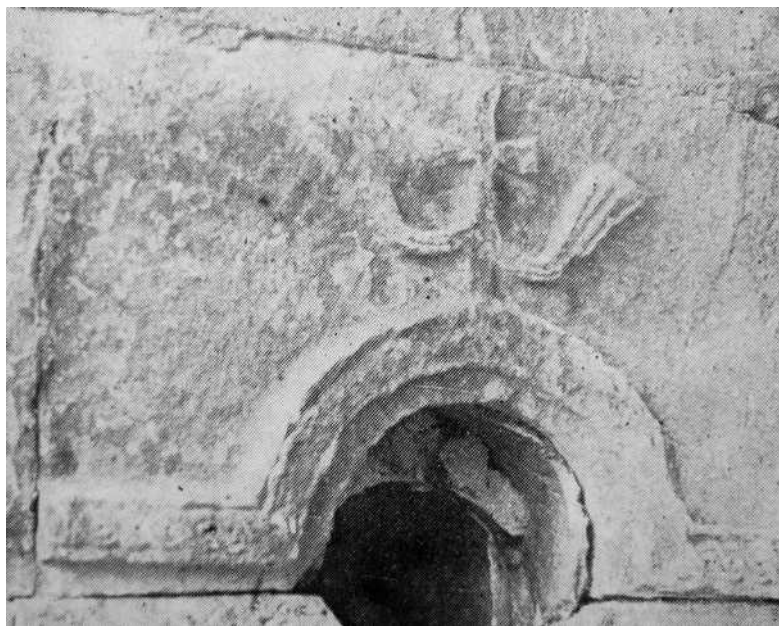
Abb. 7.7: Kirche von Ruisi, oberer Rand eines Fensters der Ostfassade, Photo W. Tulashvili, 1938, in: Čubinašvili, 1970, Abb.71.2.
