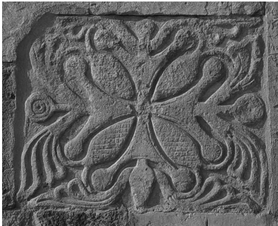
Abb. 7.6: Kirche von Ruisi, Südfassade, links vom Eingang, Detail, Irene Giviashvili 2006.
