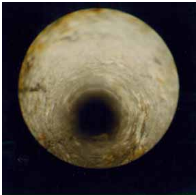
Abbildung 20: Testanlage B nach Beendigung des Versuchslaufes bei einem CO 2 -Partialdruck von 0,05 bar. Blick in Richtung des Ladewärmeaustauschers im Temperaturbereich von ca. 53 °C
