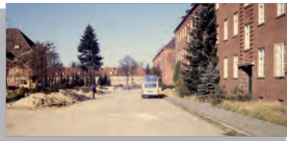
Baustelle vor Gebäude 11 (1993)
