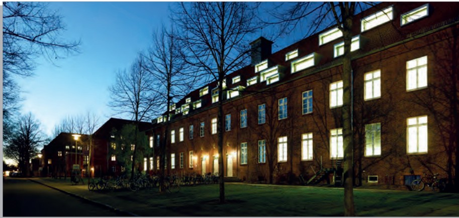
Gebäude 14 bei Nacht
