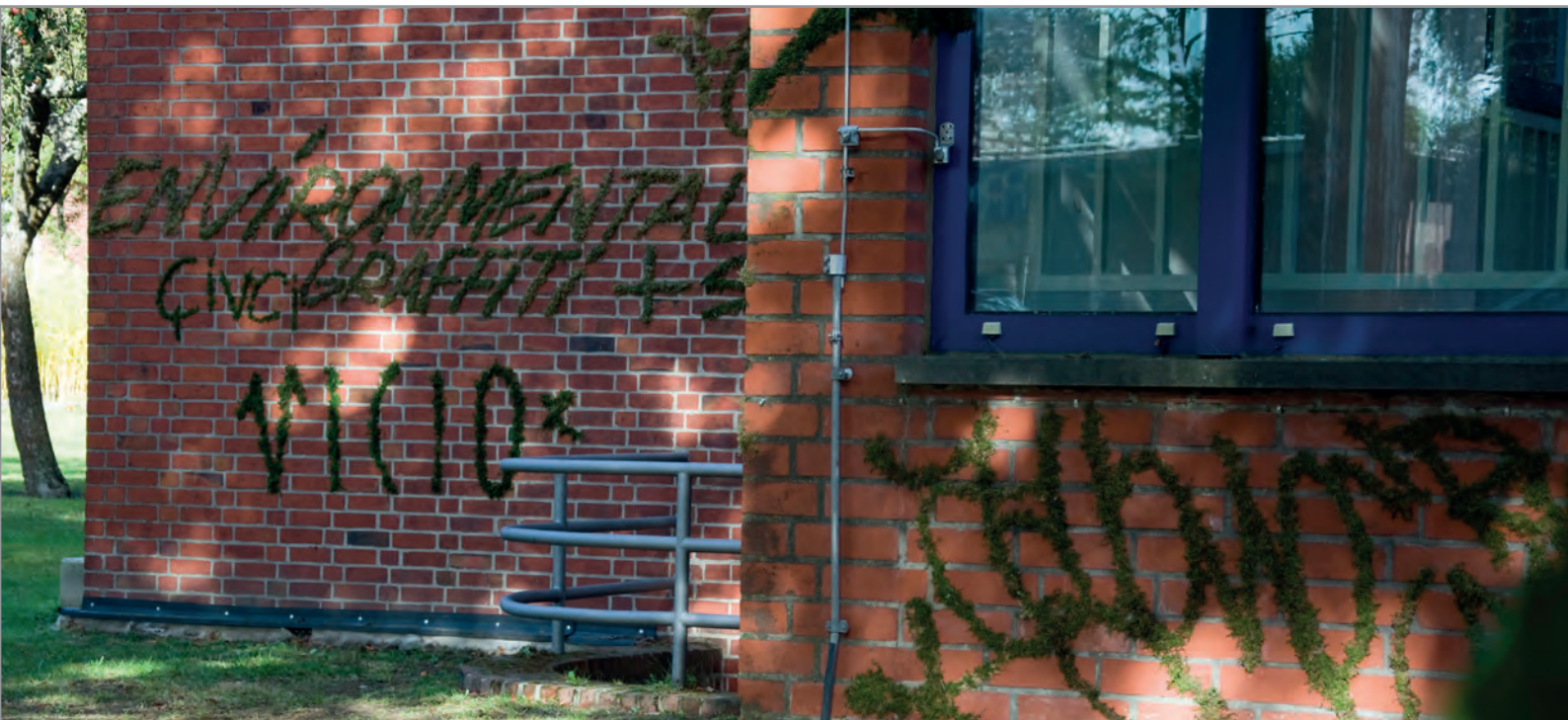
Die Moos-Installation von DTagno am Gebäude 12
