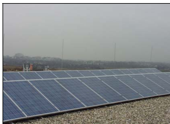
Abbildung 4: Darstellung einer starr montierten PV-Anlage
